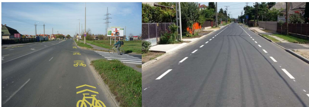
16-17. fotó: példák kerékpáros nyom Debrecenben (balra) és nyitott kerékpársáv Debrecen-Józsán (jobbra) kialakítására
