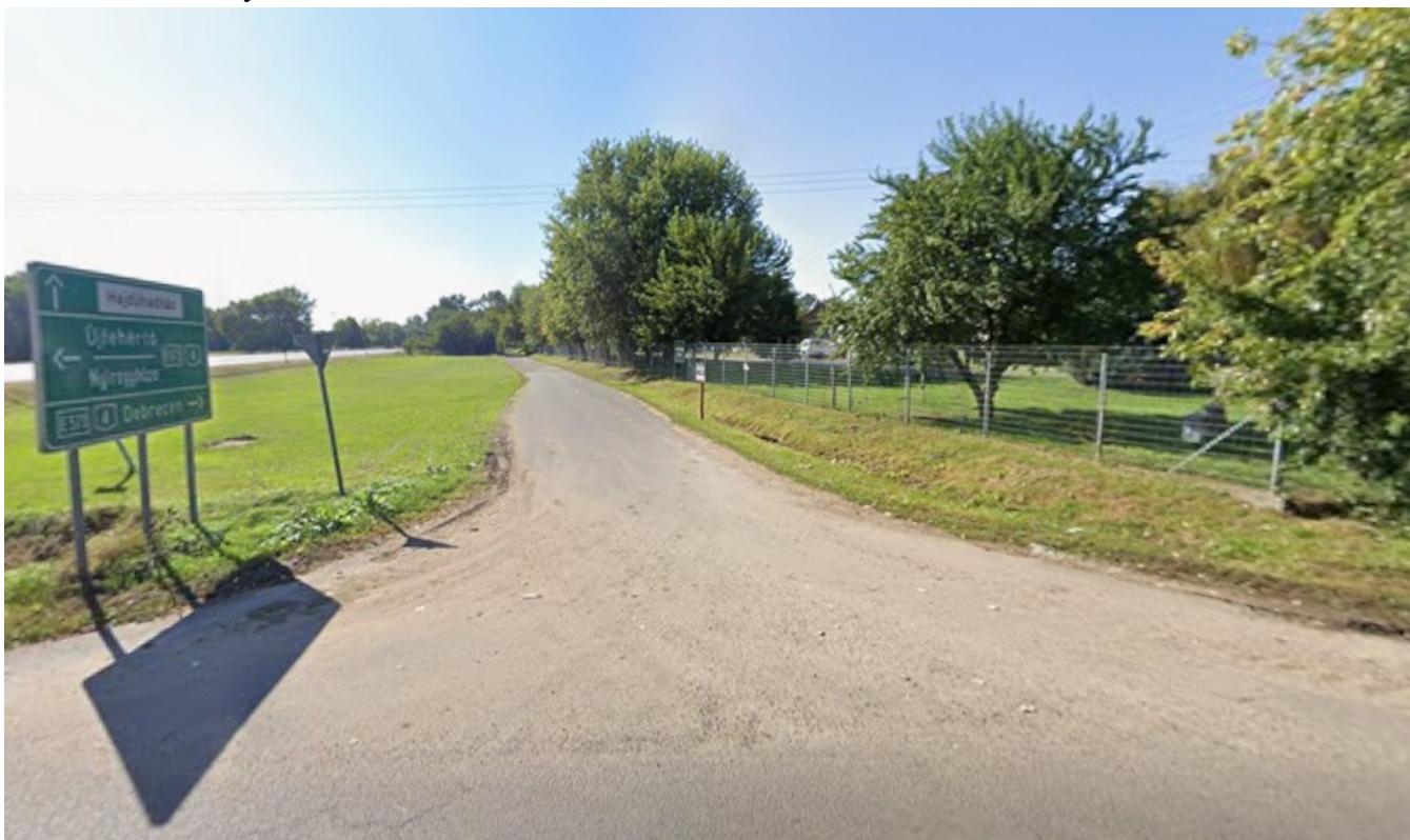
3506 sz. Hajdúvid-Hajdúhadház összekötő út és 0205 hrsz-ú ingatlanon található szervízút csomópontja Forrás: Saját fotó
